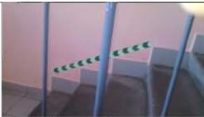
Фото № 33 – Пути эвакуации (в т.ч. зоны безопасности)
