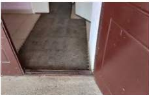
Фото № 15 – Дверь (входная) порог
