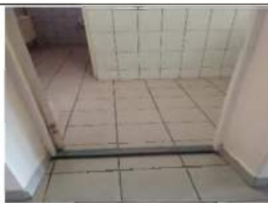
Фото № 44 – Туалетная комната
