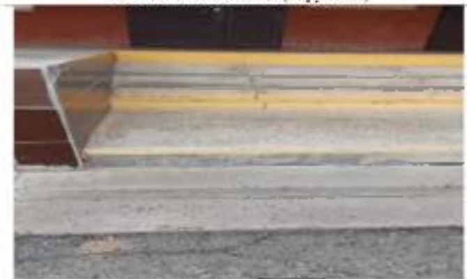
Фото № 8 – Лестница (наружная)
