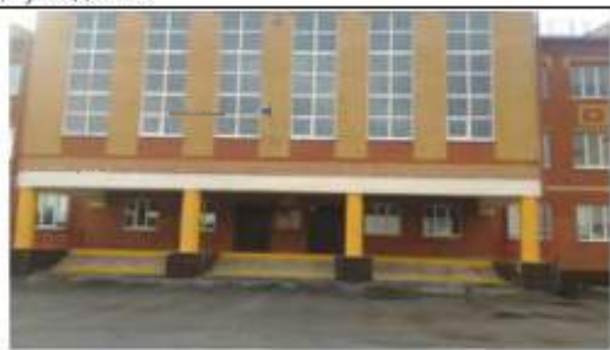
Фото № 4 – Лестница (наружная)
