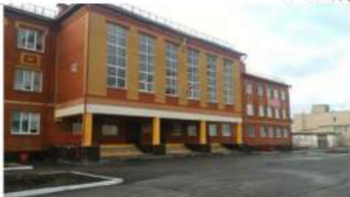
Фото № 3 – Вход (входы) в здание
