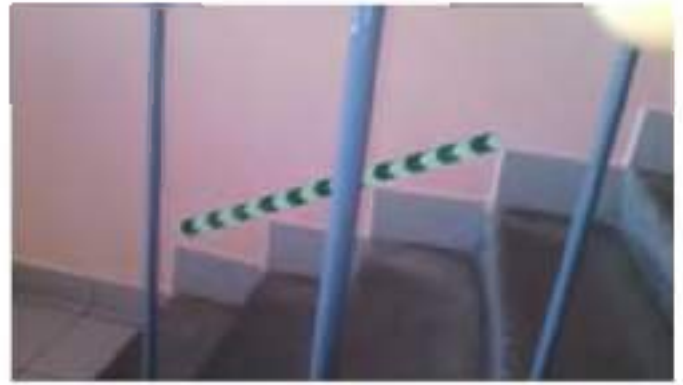
Фото № 26 – Лестница (внутри здания)
