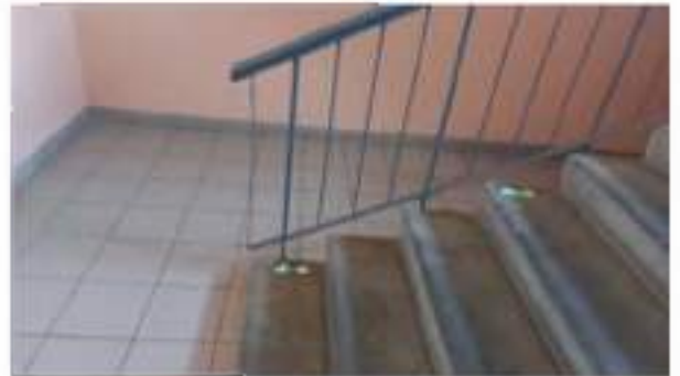
Фото № 28 – Лестница (внутри здания)
