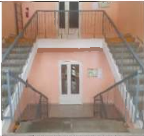
Фото № 25 – Лестница (внутри здания)
