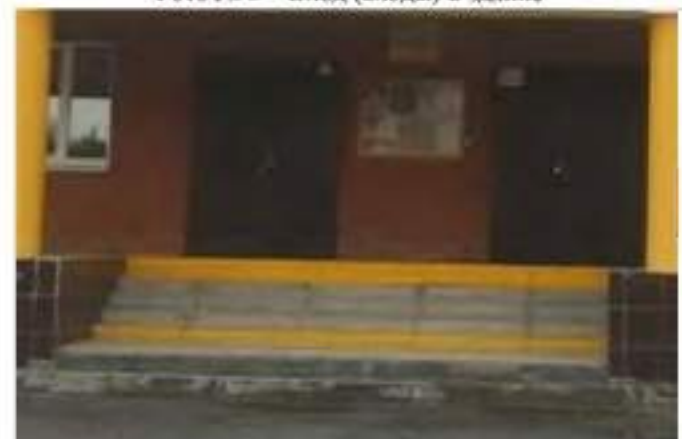
Фото № 5 – Лестница (наружная)
