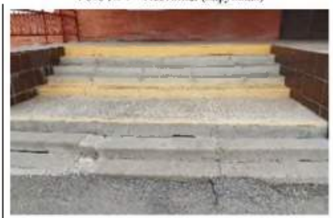
Фото № 6 – Лестница (наружная)
