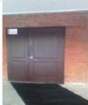
Фото № 12 – Дверь (входная)
