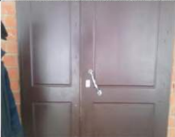
Фото № 13 – Дверь (входная)
