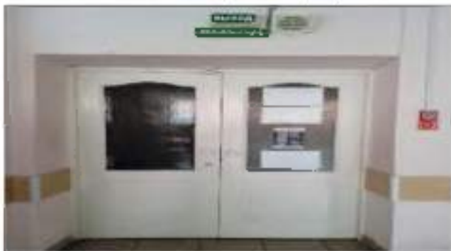
Фото № 31 – Пути эвакуации (в т.ч. зоны безопасности)
