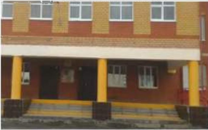
Фото № 11 – Входная площадка (перед дверью)
