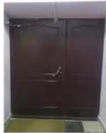
Фото № 14 – Дверь (входная)
