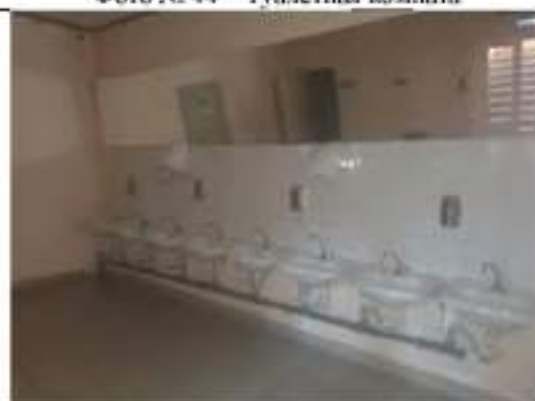
Фото № 46 – Туалетная комната
