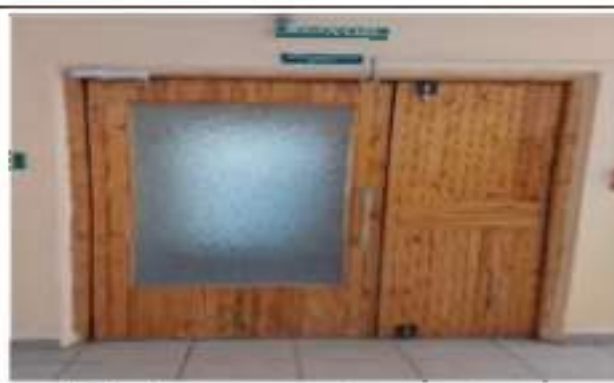
Фото № 34 – Пути эвакуации (в т.ч. зоны безопасности)
